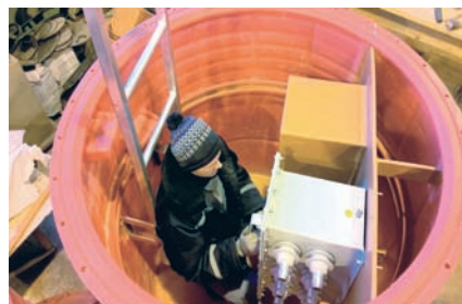
Нижний модуль полимерного колодца транспозиции, где установлены металлическая коробка транспозиции и муляж стеклопластиковой
