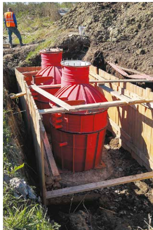
◀ Фото 1 Монтаж полимерных колодцев марки «ПРОТЕКТОР-ФЛЕКС»
