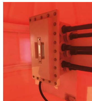
▲ Фото 6 Стеклопластиковая коробка внутри полимерного колодца
